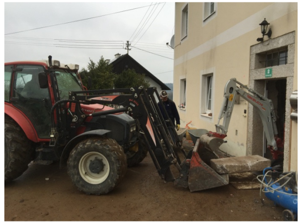
Steinblöcke austragen mit Traktor (200kg)
