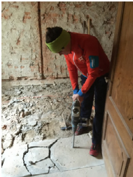
Martin Hiesmayr beim aufstemmen und entfernen des Boden beim Kellergewölbe.
