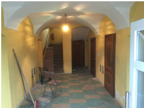
Bisheriges Vorhaus und Stiegenhaus
