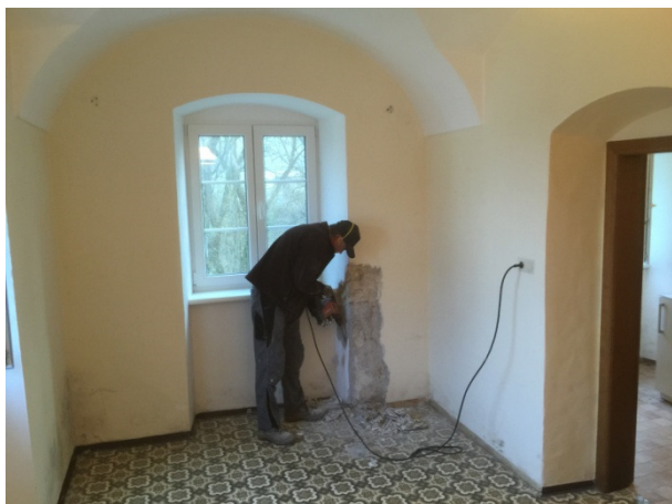
Pfanzagl Fritz und die Kameraden der FF Rohr haben die Entfernung des Verputz übernommen. Hier zu sehen Pfanzagl Fritz
